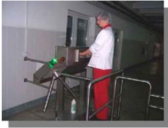
Рис. 8.3. Пропускний турнікет для дезінфекції рук і взуття
