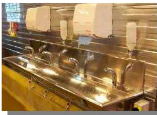
Рис. 8.2. Безконтактні дозатори та крани для миття рук
