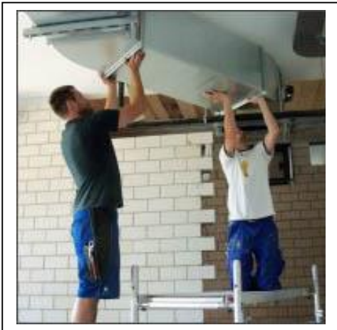
Рис. 33 - Монтаж прямокутного шумоглушника в повітроводах вентиляційної системи
