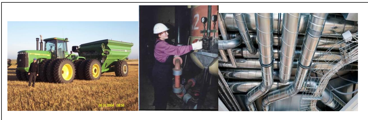
Рис. 1- Приклади виникнення механічного шуму, гідродинамічного - від руху води в трубах, аеродинамічного - від руху повітря в повітроводах
