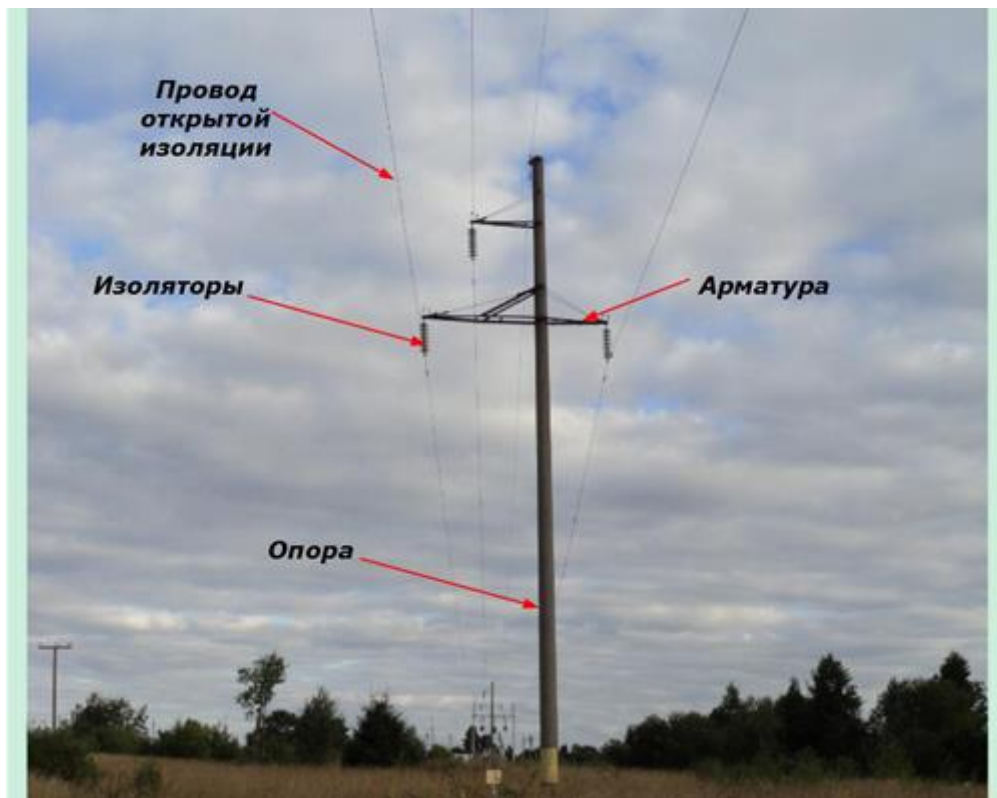
Рис. 2. Конструкція ПЛ 110 кВ
