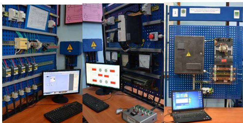
Рис. 3. Електронні пристрої для керування електроприводами
