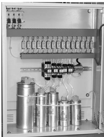
Рисунок 1 – Конденсаторна компенсуюча установка
