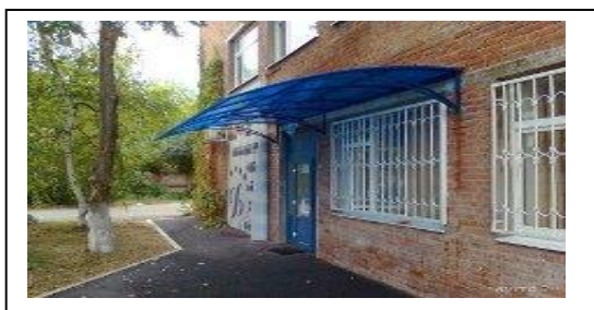
Рис. 24 - При засліпленні природним освітленням на вікна застосовують: козирки – (а), навіси – (б)
