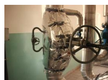
Рис. 19 - Екранування у термпічній Рис. 20 - Термоізоляція обладнання. Термопак
