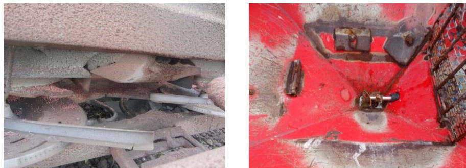
Рисунок 1 – Корозійні пошкодження машин для внесення добрив після одного сезону експлуатації
