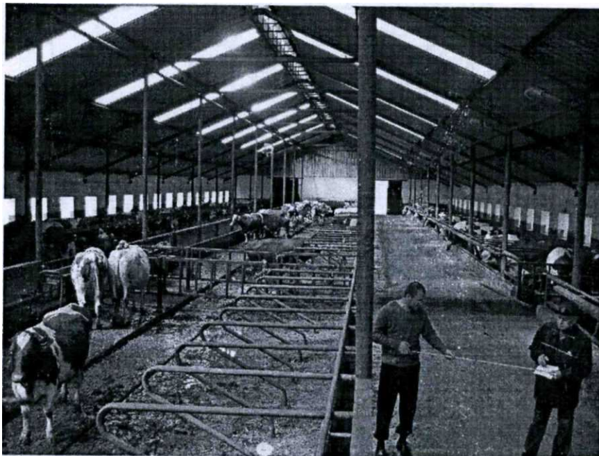
Рис. 1. Покрівля корівника з стільниковими полікарбонатними листами на молочному комплексі ВАТ «Насіневе»
