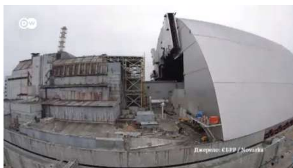
Рис. 3. Завершення будівництва бетонного укриття зруйнованого реактора та спорудження металеве арочного укриття (конфайнмента) та його насунання 29.11.2016 року – завершено грандіозний процес насунання Нового безпечного конфайнмента над четвертим енергоблоком ЧАЕС. За два тижні арка пододала 327 метрів. Термін експлуатації нового укриття - 100 років. http://www.dw.com/uk
