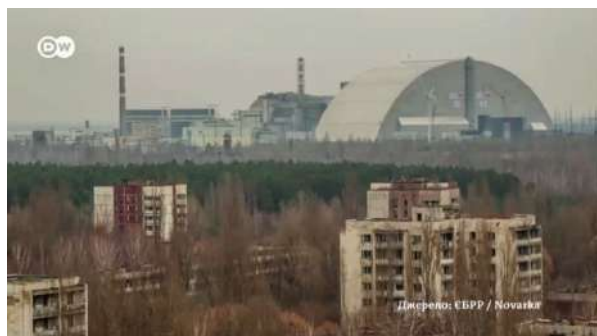
Рис. 3. Завершення будівництва бетонного укриття зруйнованого реактора та спорудження металеве арочного укриття (конфайнмента) та його насунання 29.11.2016 року – завершено грандіозний процес насунання Нового безпечного конфайнмента над четвертим енергоблоком ЧАЕС. За два тижні арка пододала 327 метрів. Термін експлуатації нового укриття - 100 років. http://www.dw.com/uk
