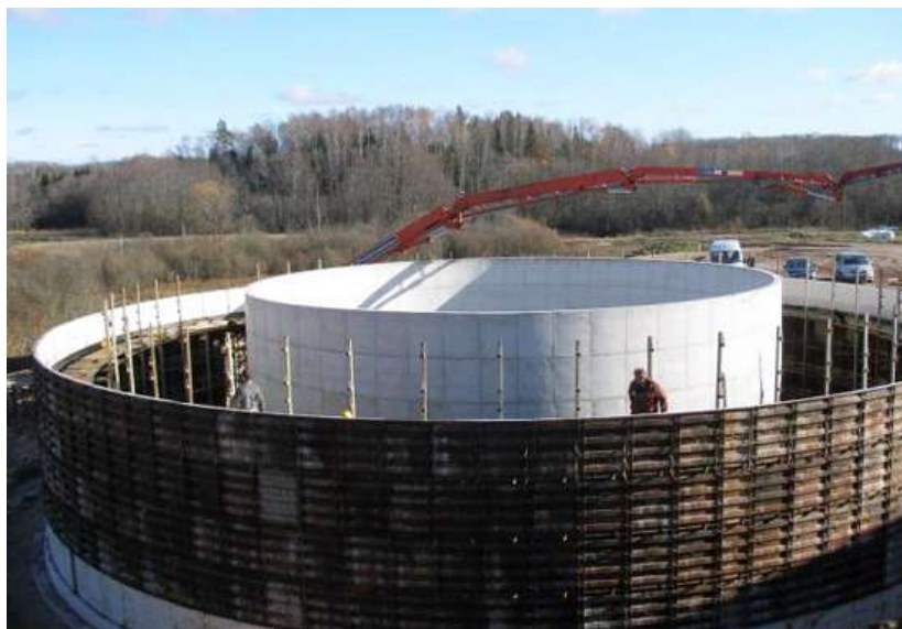
Рис. 11. Будівництво біогазової установки в селі Копанки Івано-Франківської області.
