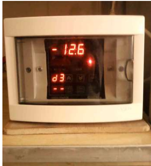
Рис.2.1 – Загальний вигляд вимірювача-регулятора багатофункціонального восьми канального ОВЕН ТРМ 138-Р із автоматичним перетворювачем інтерфейсів ОВЕН АС 4 [323]
