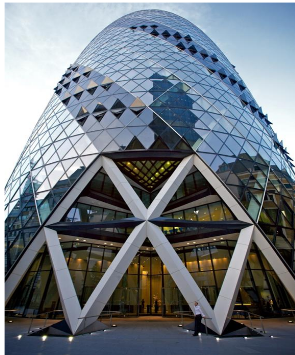
Рис. 2.13 Оболонкові системи. Вежа Мэрі-Экс (Лондон),
