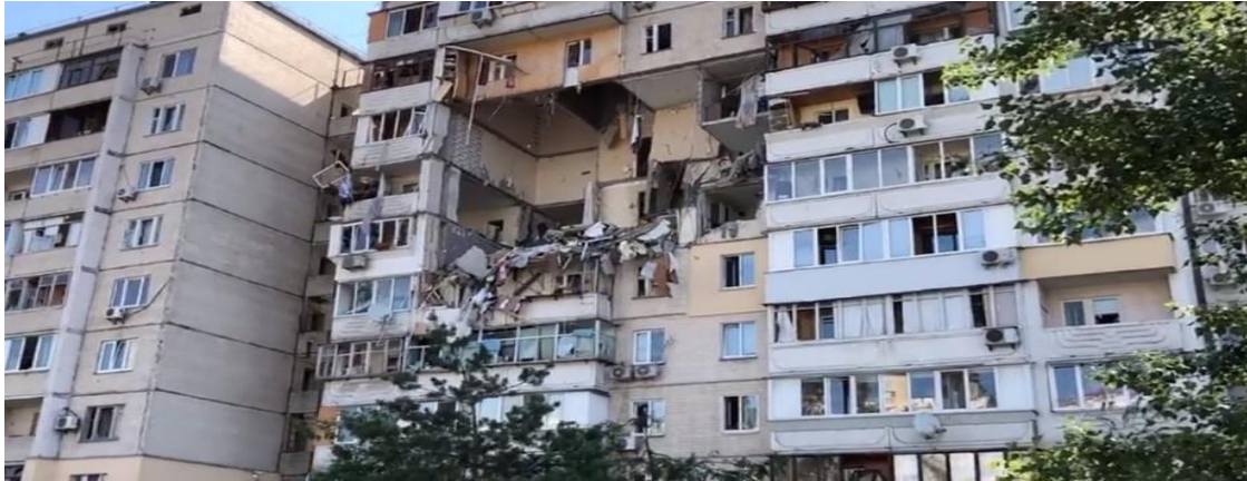
Рис. 2.8 Напівзруйнований будинок на Позняках
