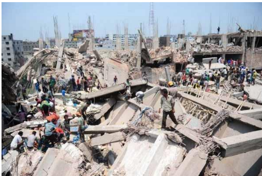
Рис. 1.4 – Повне руйнування будівлі
