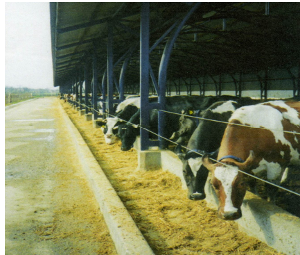
Рисунок 2 – Кормовий майданчик з кормовим столом під накриттям від непогоди
