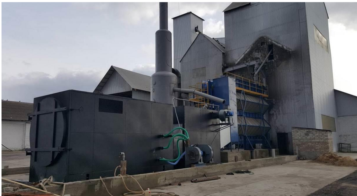
Рис. 1 – Загальний вигляд теплогенератора зібраного у технологічну лінію
