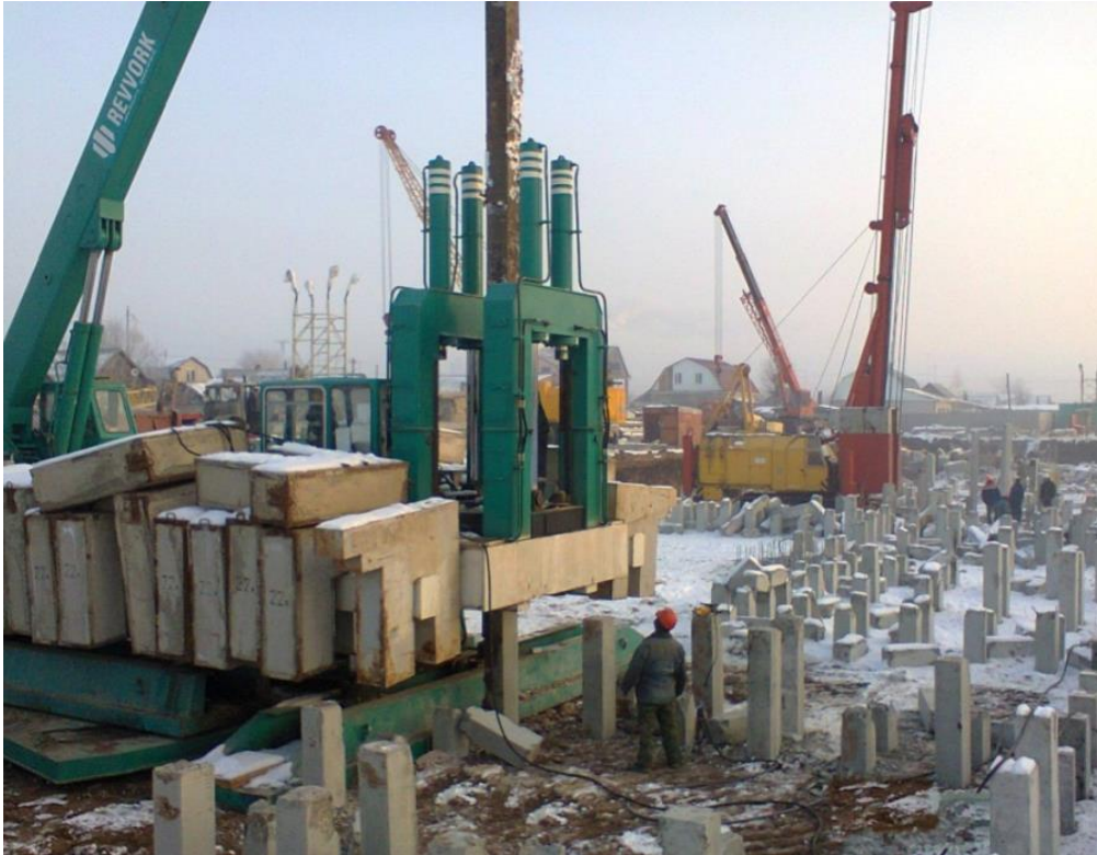
Рис.2. Вдавлювання палі лінійним методом
