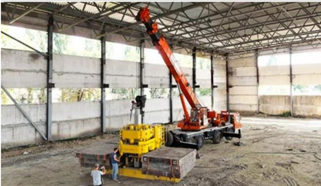
Рис.1. Вдавлювання палів крапковим методом
