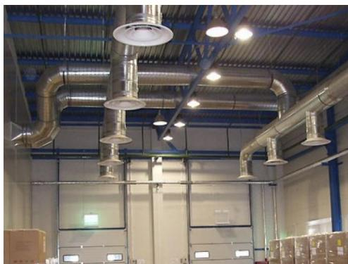
Традиційно система повітряного опалення виконує функції опалення, механічного очищення (від пилу) і припливної вентиляції. А якщо додати всі опції, то отримаємо тонке очищення повітря (електронний і вугільний фільтр), зволоження повітря, охолодження (у спеку) і бактеріологічну очищення повітря (УФ-стерилізатор), температурне зонування
