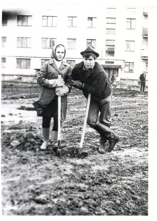
Володимир Пузік на будівництві навчального містечка
