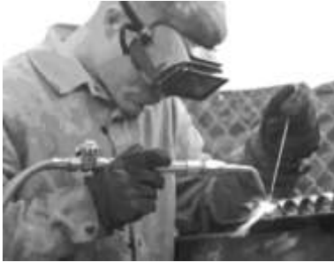
Газове зварювання Oxy-acetylene welding
