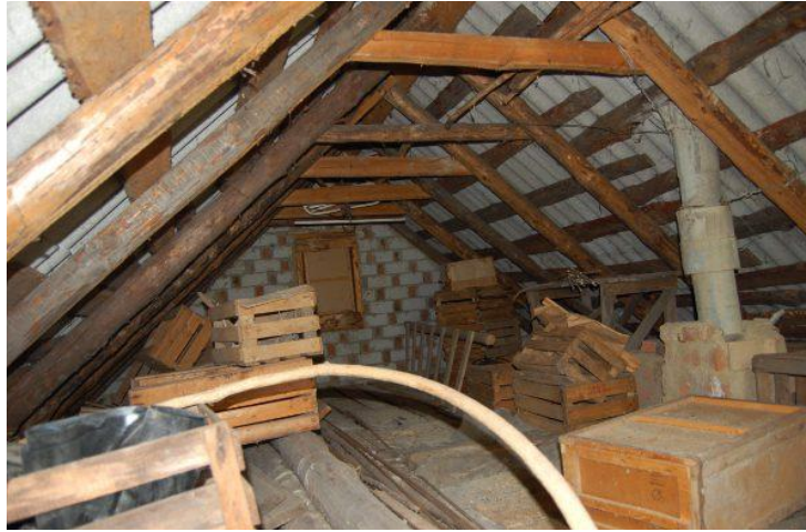
Рисунок 46. Приміщення з підвищеною небезпекою
