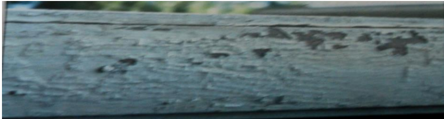
Рисунок 2.9 – Розтріскування з луценням
