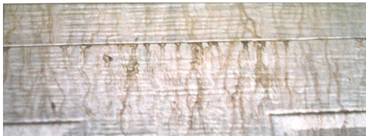
Рисунок 2.19 – Вилуговування поверхнево-активної речовини
