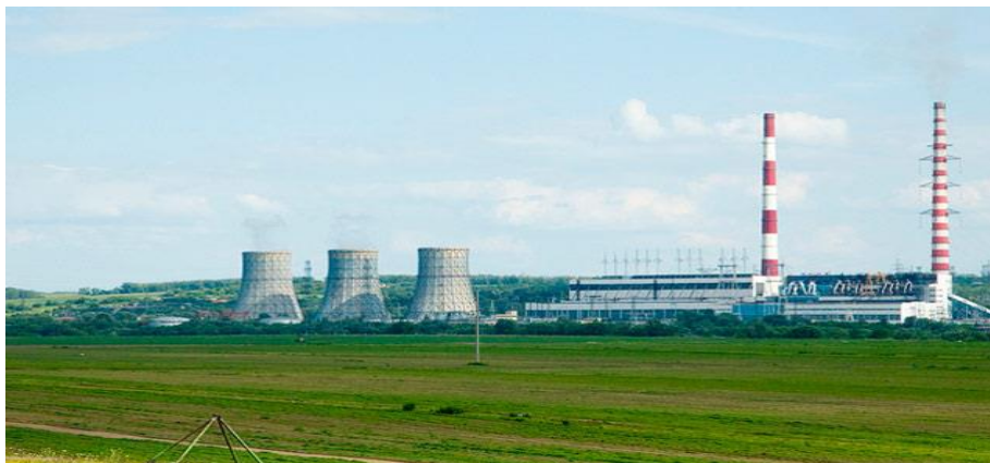
Рис. 1– Вторинно переробна станція
