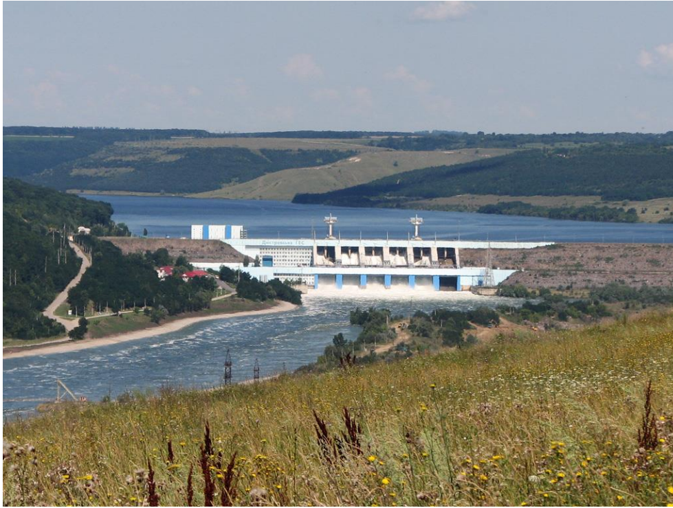
Рисунок 11. Дністровська ГЕС 702 МВт (6×117 МВт). Середньорічне вироблення е/е – 865 млн. кВт·год, при максимальному напорі 54,5 метрів
