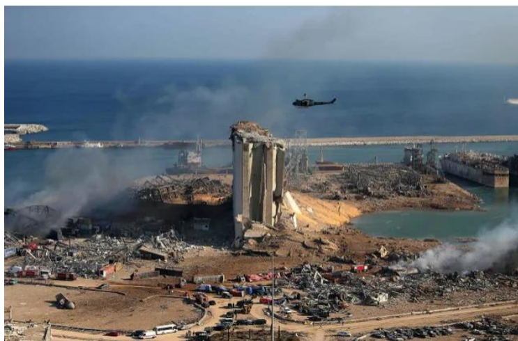
Рис. 4.10 – Зруйнований елеватор і руїни Бейрута
