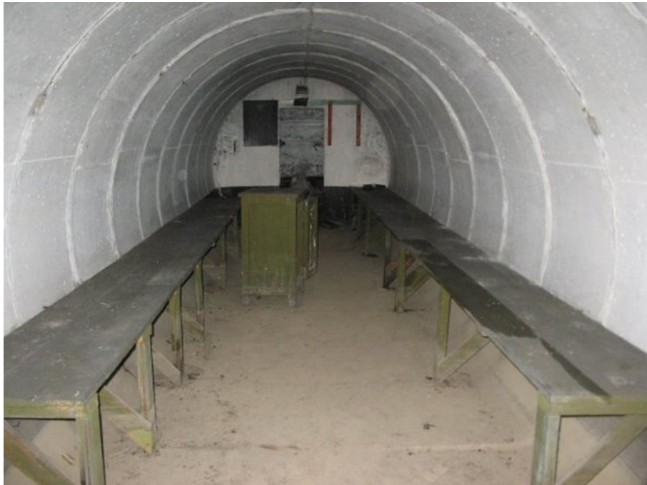
Рис. 6.7 – Швидкосторуджувана захисна споруда цивільного захисту із залізобетонних кілець
