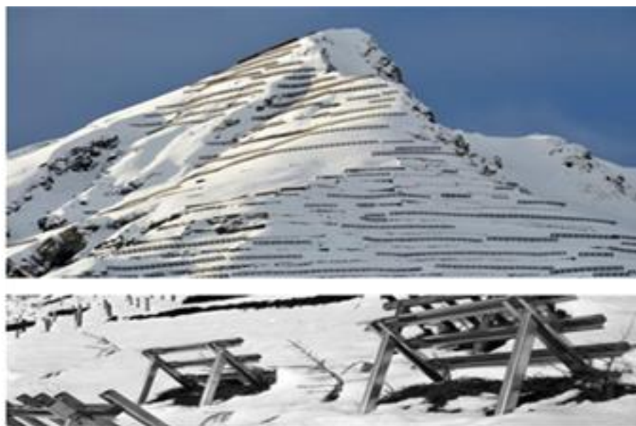
Рис. 7.6 – Сучасні протилавинні бар'єри на горі Шіахорн над містом Давос в східній частині Швейцарії
