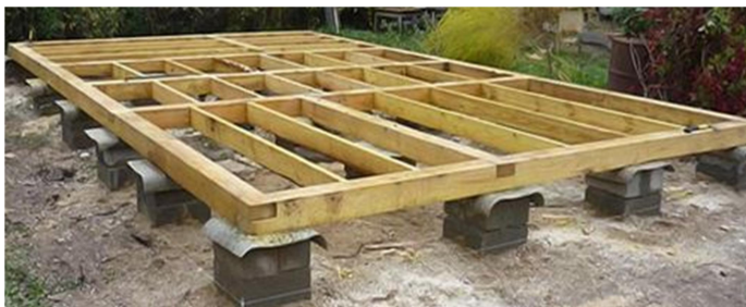
Рис. 2. Стівпчастий фундамент
