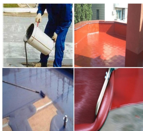
Рис. 22. Наливна покрівля
