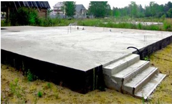
Рис. 3. Суцільний плитний фундамент
