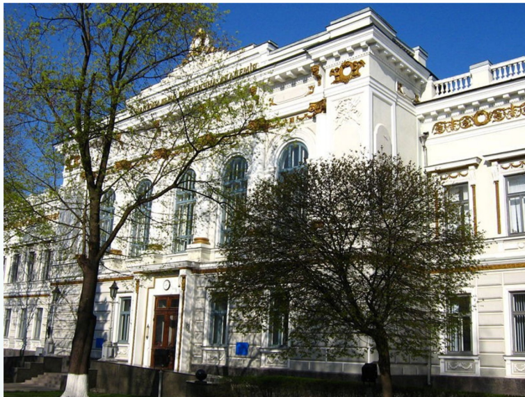
Сучасний вигляд будівлі Харківського комерційного училища (сьогодні Харківський національний юридичний університет ім. Ярослава Мудрого)
