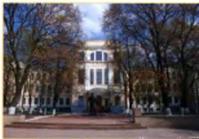
Administrative building of University Головний корпус університету Главный корпус университета
