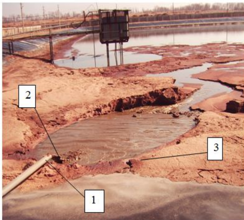
Рис. 4. Фрагмент става - накопичувача рідкої фракції, яка подається з сепаратора BAUER S655.
