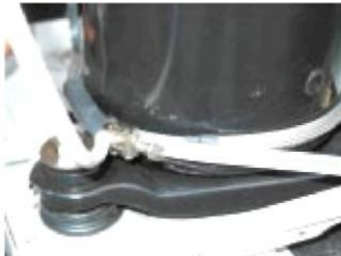
Рисунок 6.44 – Встановлений нагрівач картера
