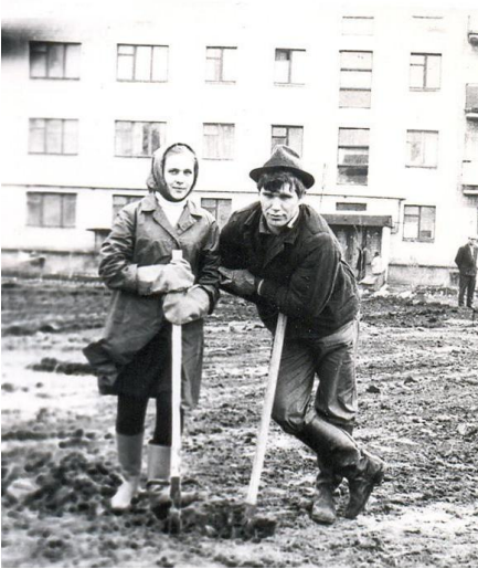
В. Пузік на будівництві навчального містечка
