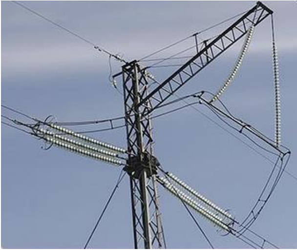
Рисунок 3 – Розщеплення фазного провода на три ПЛ 500 кВ.
