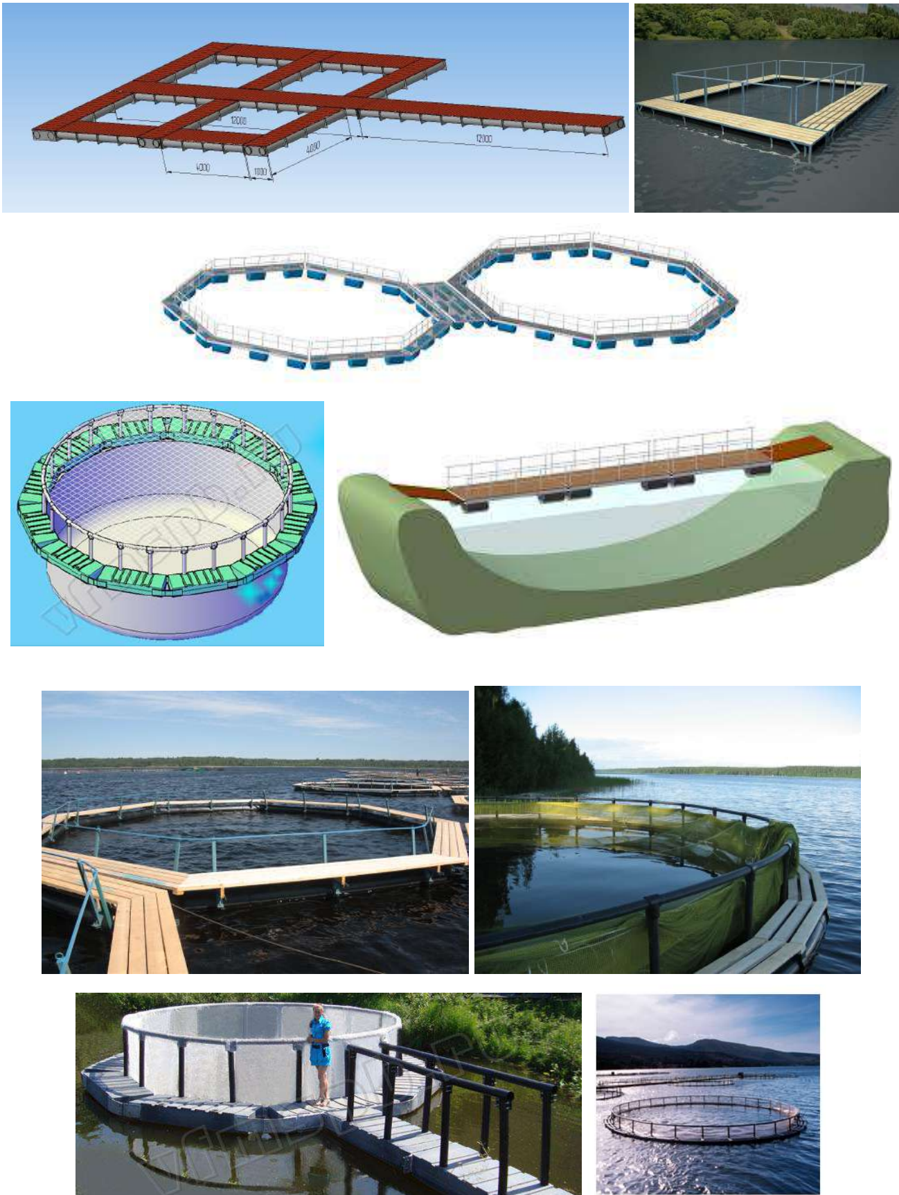
Рис. 1. Різновидності понтонних садків для вирощування риби
