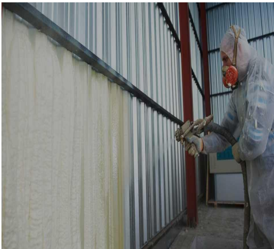
Рисунок 2 – Утеплення пеноізолом
