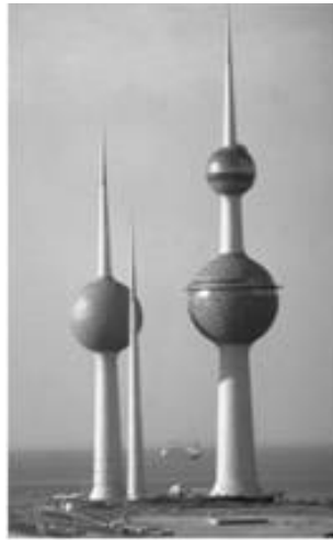
Рис. 76. Водонапірна вежа. Кувейт, 1979 г.
