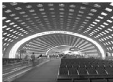
Рис. 85. Пряма еліптична циліндрична поверхня - секція Е терміналу аеропорту ім. Ш. де Голля. Франція, м. Париж
