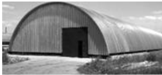
Рис. 78. Багатофункціональна швидкобудуєма бескаркасна аroachна будівля з тонколистової оцинкованої сталі
