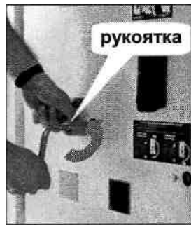
Рис. 2.7 – Відкручування елемента викочування
