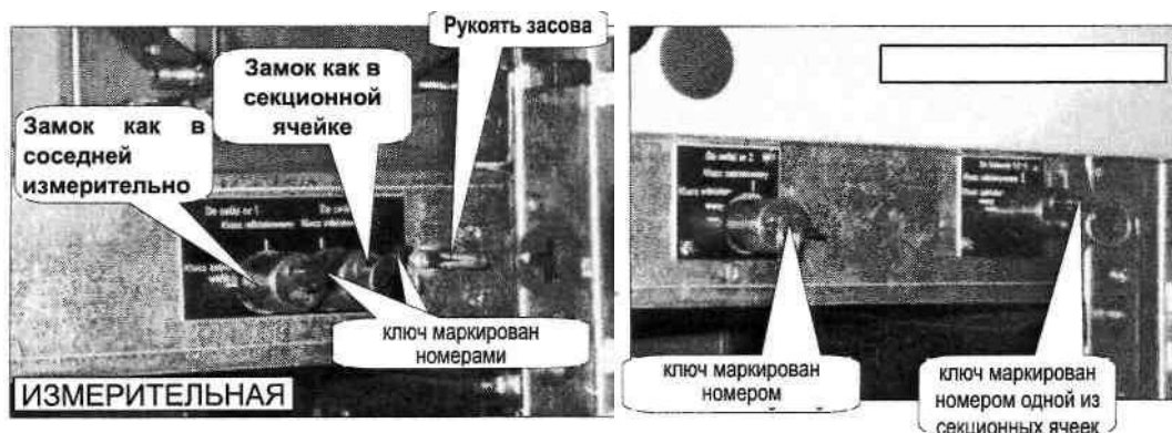
Рис. 2.1 – Замкове блокування VZ-1
