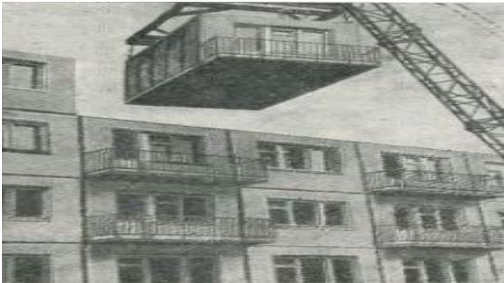
Рис. 2.12 Об'ємно-блокова система будівель
