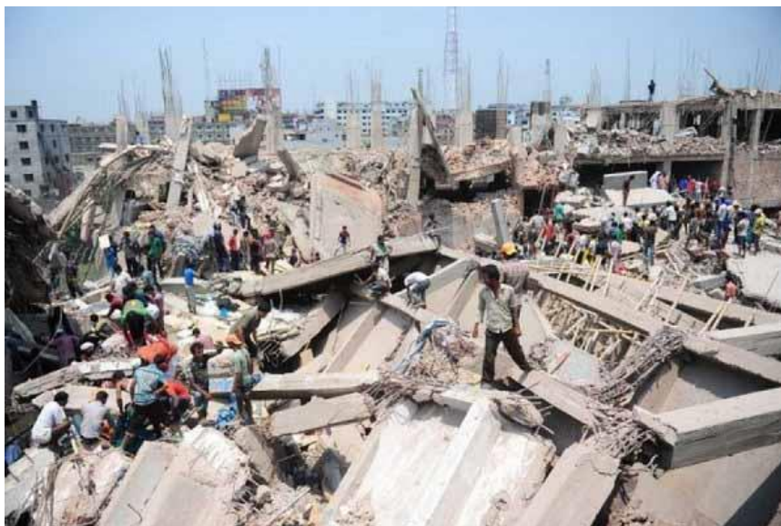
Рис. 1.4 – Повне руйнування будівлі
