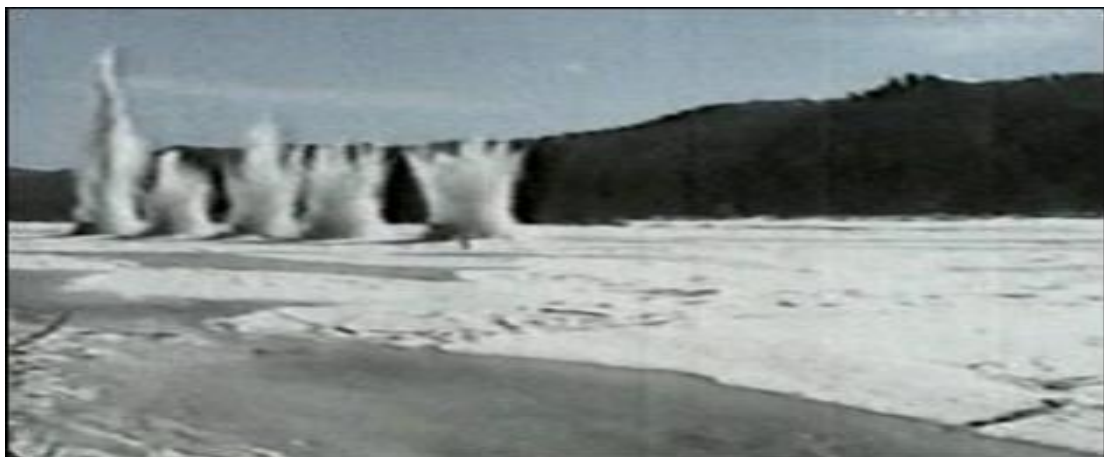
Рис. 3.1 Підривання льоду на річці з метою відвертання повені
