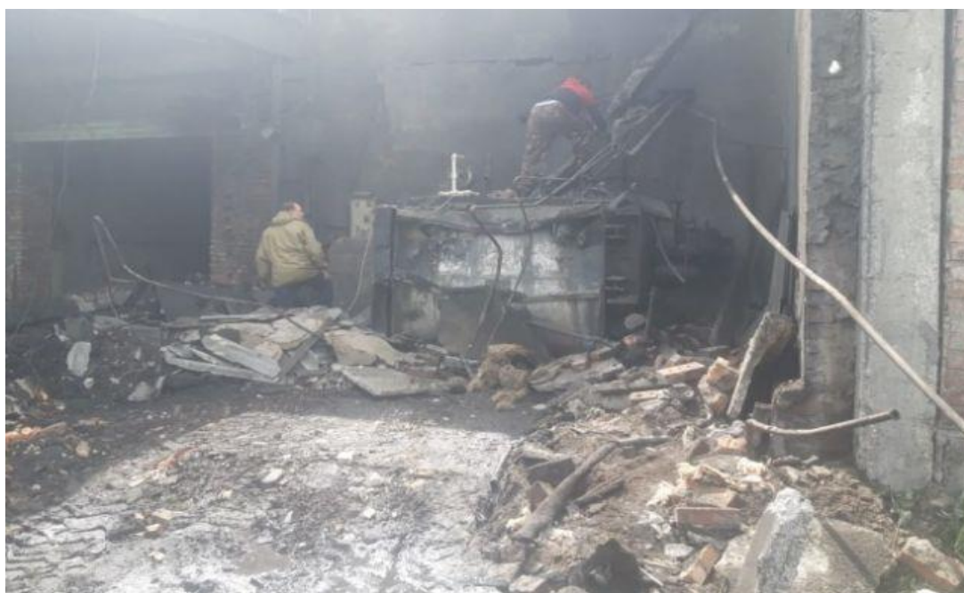
Рис. 1.2 Наслідки вибуху котла на молокозаводі
