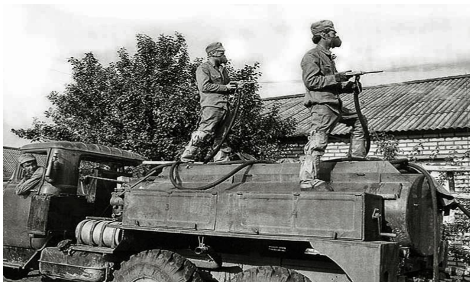
Рис. 4.9 Проведення дезактивації житлових будинків при ліквідації наслідків аварії на ЧАЕС, 1986 рік.
