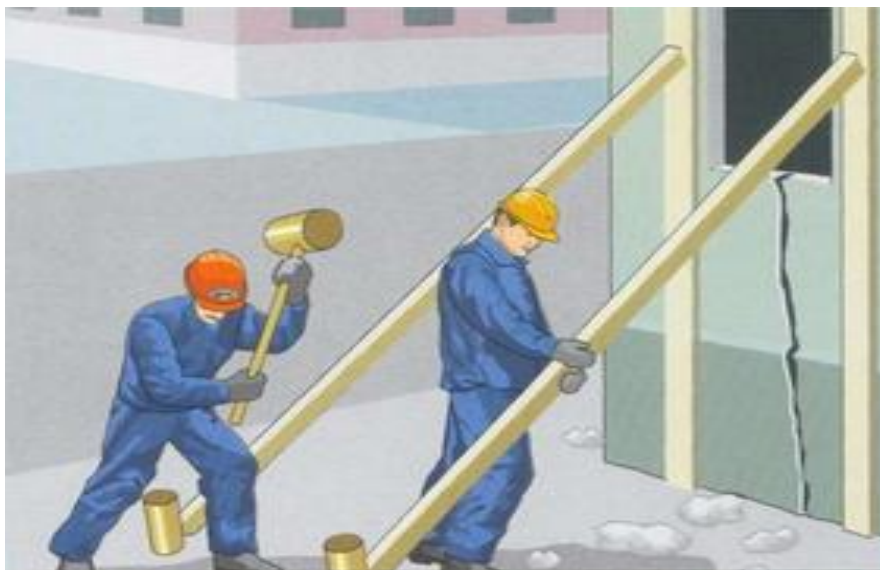
Рис. 4.5 Зміцнення або обвалення конструкцій будівель і споруд, загрозливих обвалом або перешкоджаючих безпечному проведенню рятувальних робіт
