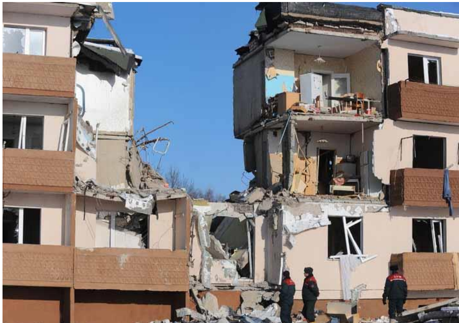
Рисунок 4.8 – Сильне руйнування будівлі
