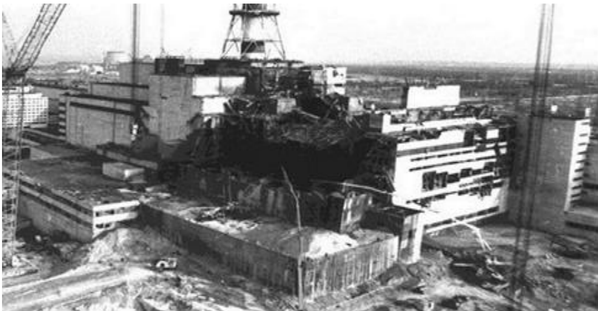
Рисунок 1.6 – Вид зруйнованої споруди 4-го енергоблоку,
