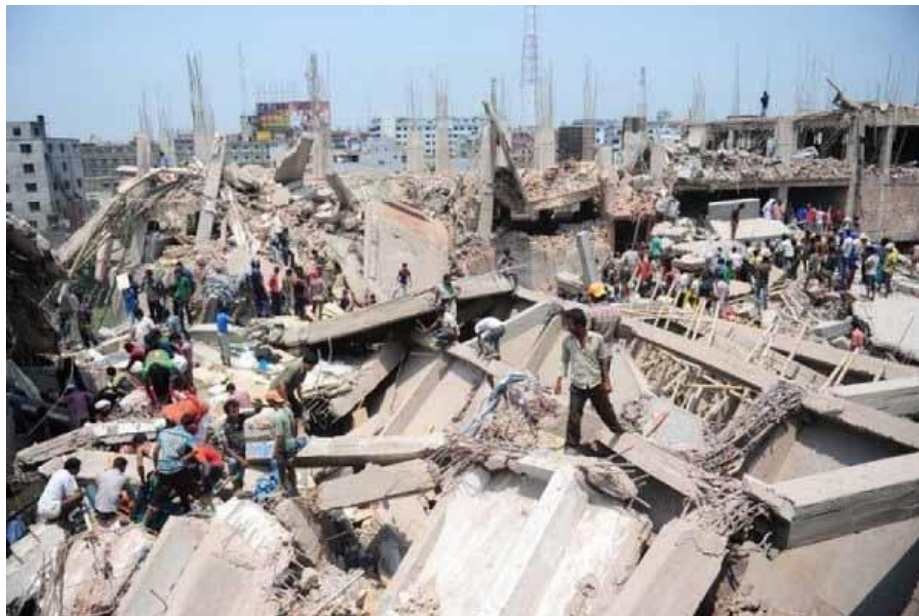
Рисунок 4.9 – Повне руйнування будівлі
