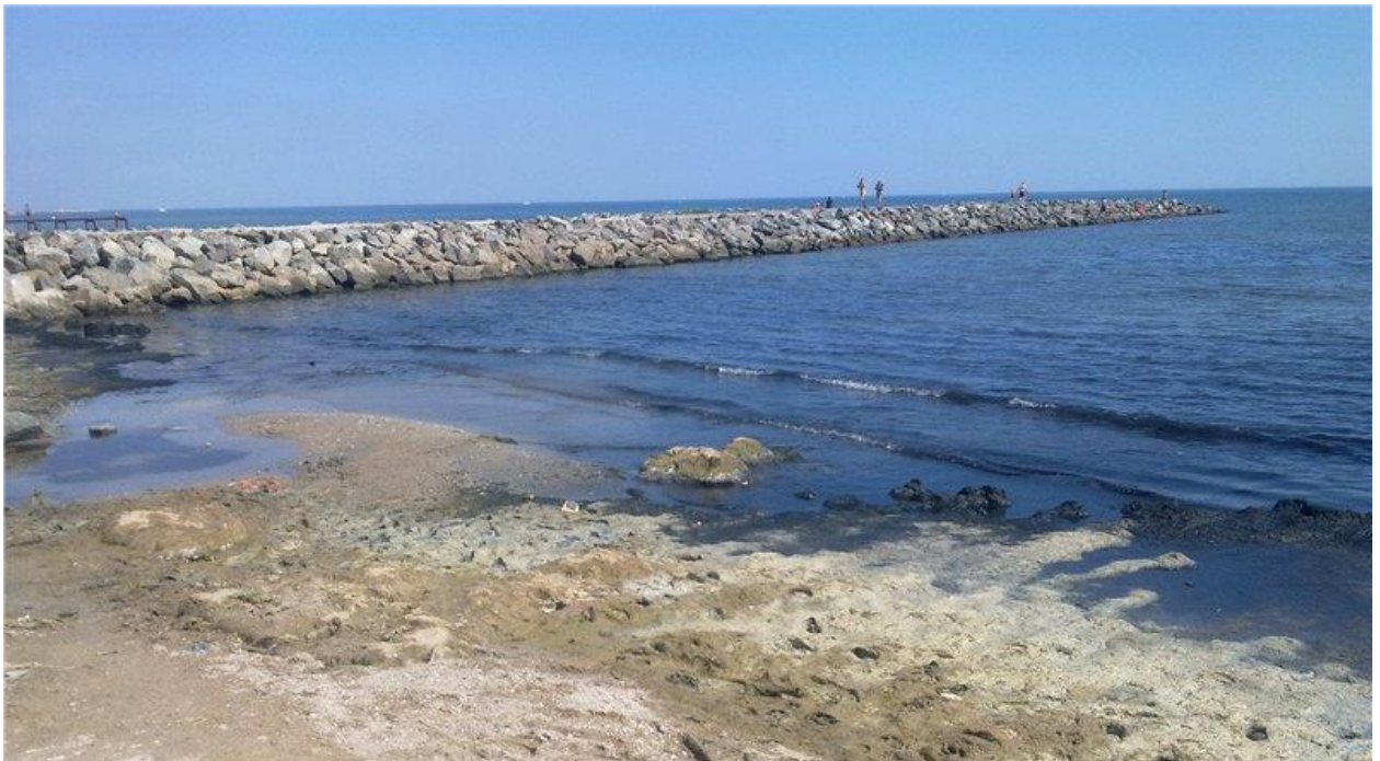
Рисунок 7.10 – Кріплення берегу кам'яно-накидними бунами
