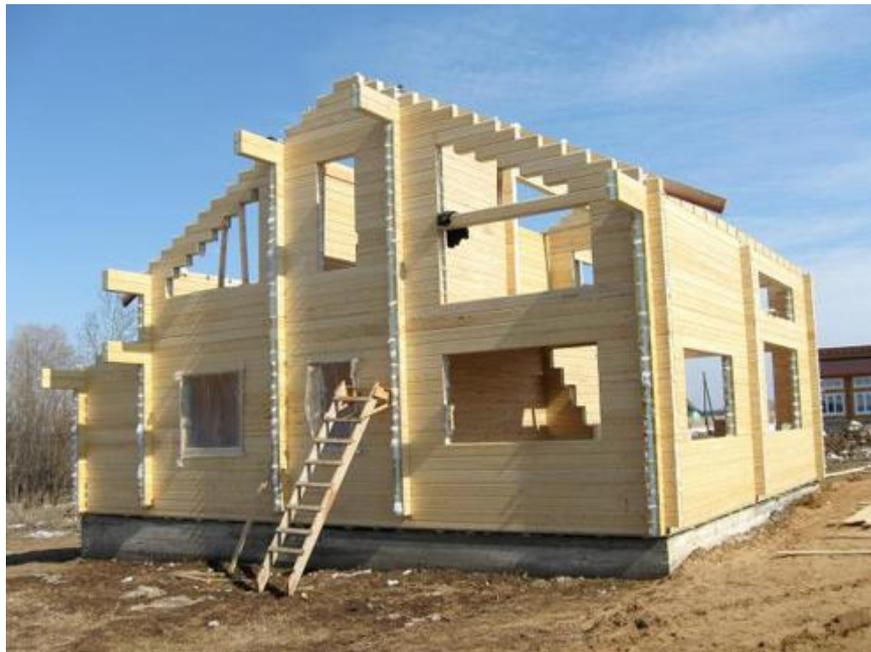
Рисунок 3 - Монтаж здания из клееного бруса.
