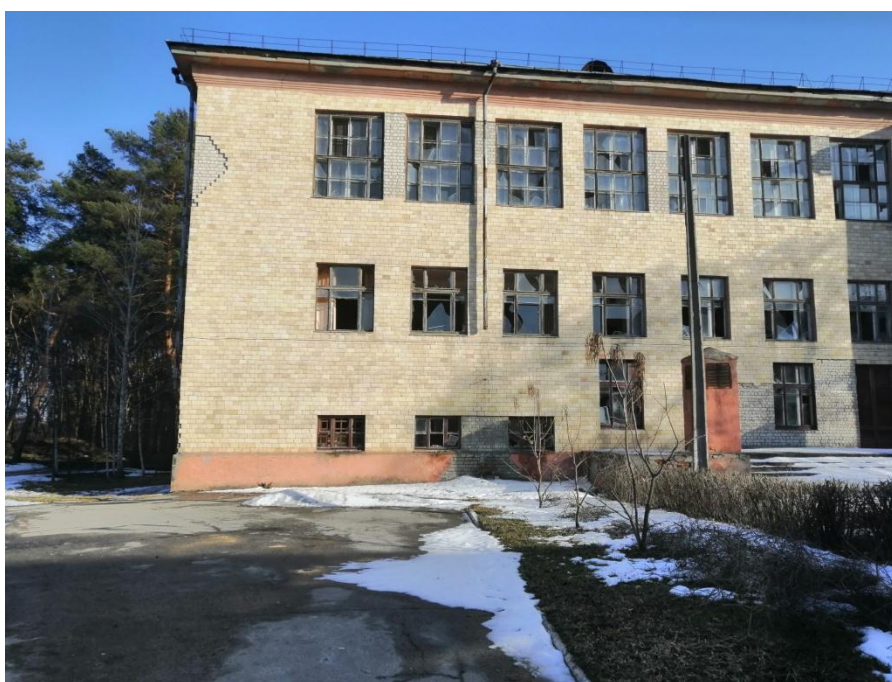
Фото 3. Вибиті шибки у приміщенні клубу ДБТУ. 25.02.2022
