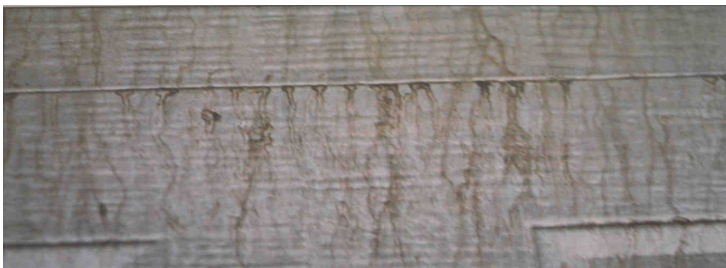
Рисунок 2.19 – Вилуговування поверхнево-активної речовини
